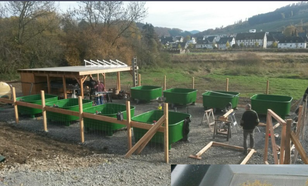
Brutanlage Lars Brackwehr (im Bau 2016) www.ruhrtalforelle.de
