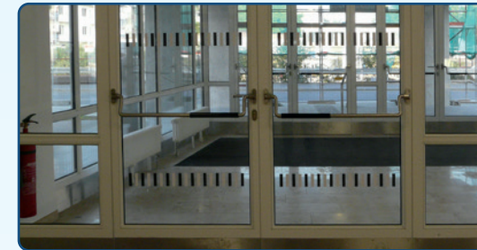
Glastür mit deutlichen Markierungen in DIN-gerechter Höhe
