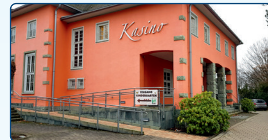
DIN-gerechte Rampe (INI Casino, Lippstadt)
