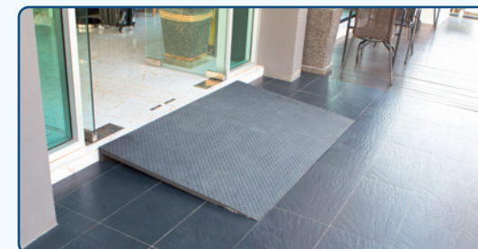
Lösung für eine individuell angefertigte Rampe. Es fehlt die DIN-Vorgabe: „breiter als die Tür mit seitlicher Aufkantung“
