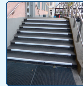
Treppe mit markierten Stufen und beidseitigen über die Stufen hinausgehenden, abgerundeten Handläufen, rechts zusätzlich tiefer Handlauf (Rathaus, Soest)
