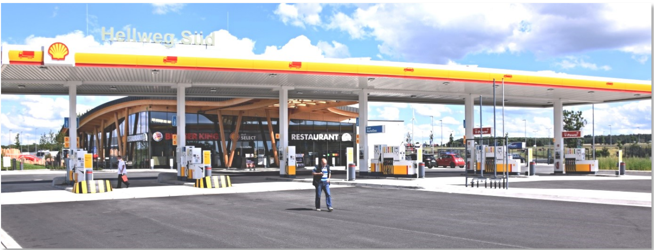
Die Tank- und Raststätte Hellweg-Süd, von der Einfahrt aus gesehen.
