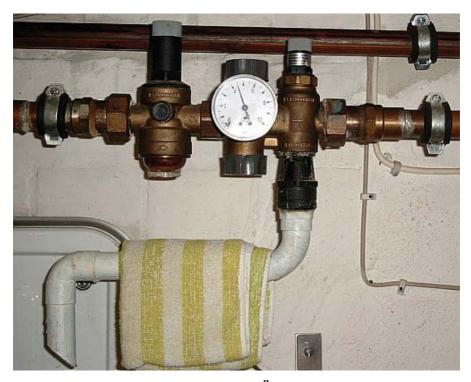
Sicherungsarmatur (mit Manometer) gegen Überdruck und Rückfließen
