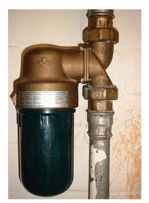
Eingangswasserfilter zur Rückhaltung von Partikeln, die aus dem zentralen Versorgungsnetz angeschwemmt werden.
